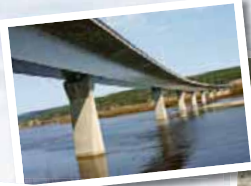
Den 1000 m långa järnvägsbron över Ångermanälven är färdig och spåret är lagt.
