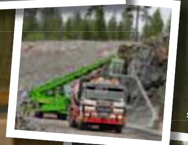
Bergförstärkning längs industri-spåret i Husum.
