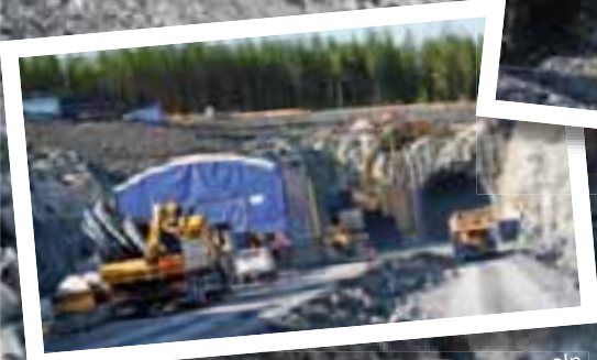
Namntalltunnelns norra mynning. I oktober är tunneln färdigsprängd (6 km).
