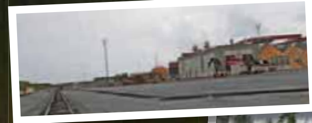
Lastplanen och spåret är byggt på M-reals fabriksområde i Husum.
