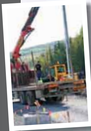
Kontaktledningsstolpar monteras på järnvägsbanken i Sidensjö.
